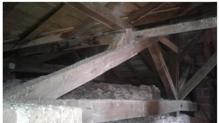
*Fils en l'air, débris inflammables (coquilles de noix) accumulés par les volatiles = **risque d'incendie.***
